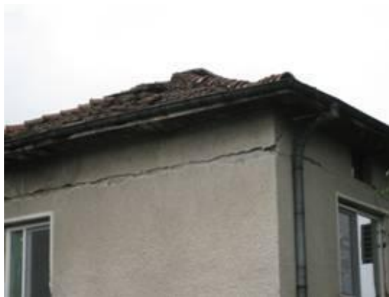
Фиг. 13 Срязвания на зидарията http://www.niggg.bas.bg/
