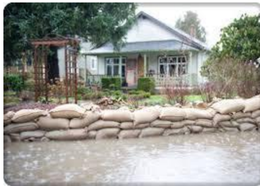
Фиг. 6.1 Защитна дига с чували с пясък
