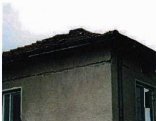
Фиг. 13 Срязвания на зидарията http://www.niggg.bas.bg/
