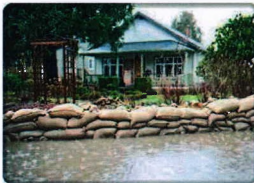
Фиг. 6.1 Защитна дига с чували с пясък
