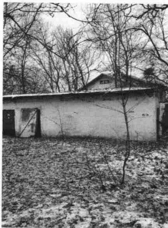
Жилищна сграда зад склад на бившото хранилище
