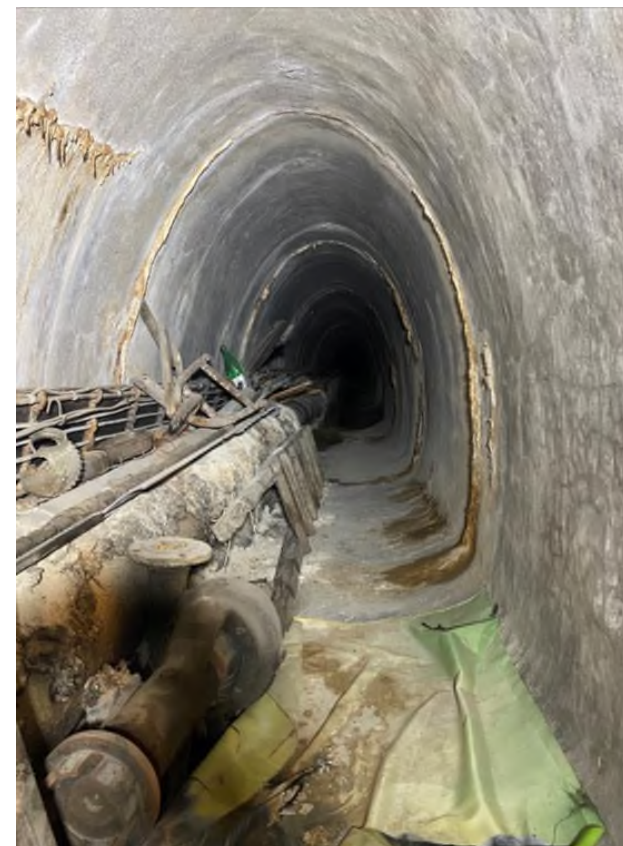
← Поглед към входа на тунела откъм помпената станция за достигане на каптажа на извора; → Работна помпа и тръби към канализацията и чешмите за обществено ползване 7
