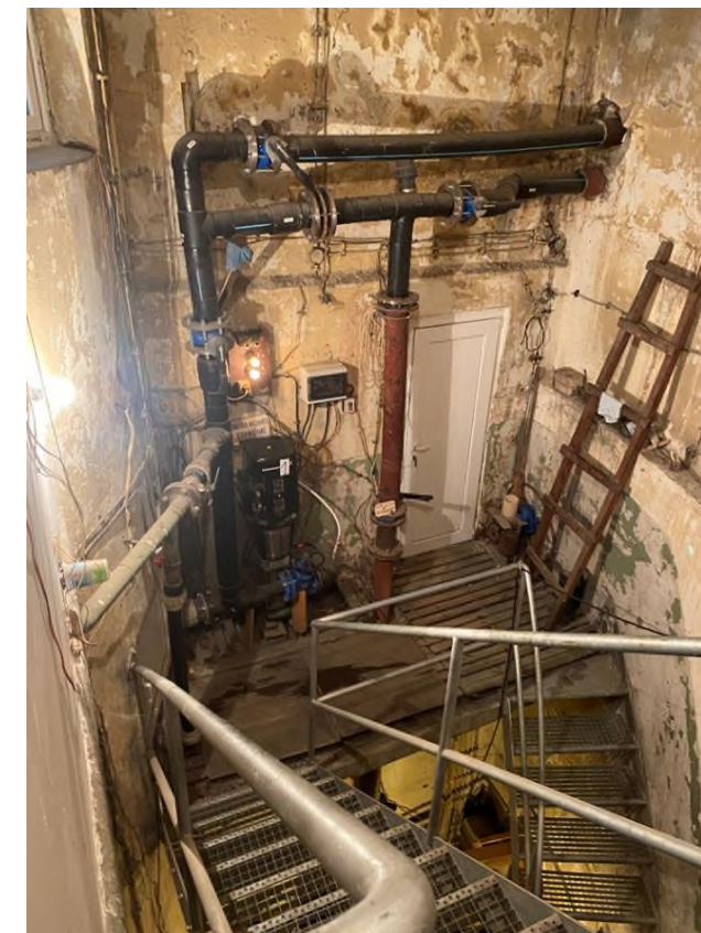
← Поглед към входа на тунела откъм помпената станция за достигане на каптажа на извора; → Работна помпа и тръби към канализацията и чешмите за обществено ползване 7
