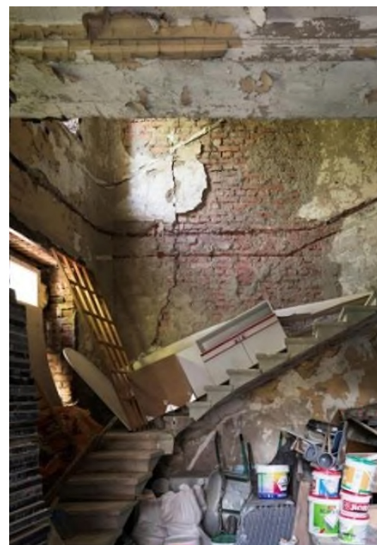
← Северно крило – входен вестибюл – значителна вертикална пукнатина в зоната на стълбището, необходимост от разчистване от строителни материали; → Вътрешен двор на сградата на ЦМБ – необходимост от разчистване на пространството
