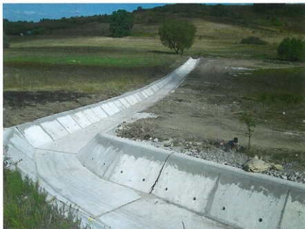
Язовир „Мърчаево” – отводящ канал след ремонта
