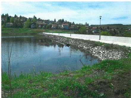
Язовир „Мърчаево“ – язовирна стена след ремонта
