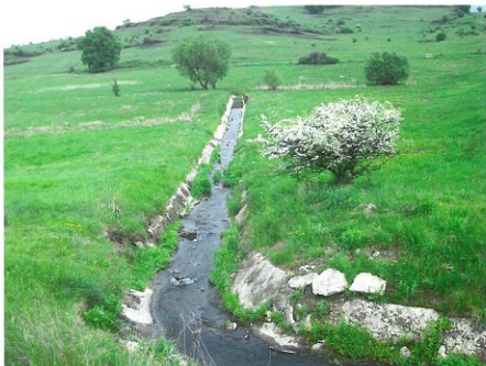
Язовир „Мърчаево” – отводящ канал след ремонта
